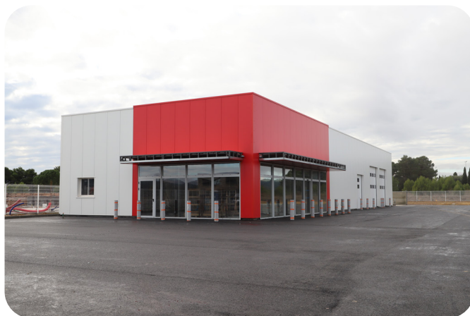
Bâtiment destiné à accueillir l'entreprise Loxam en fin de construction
