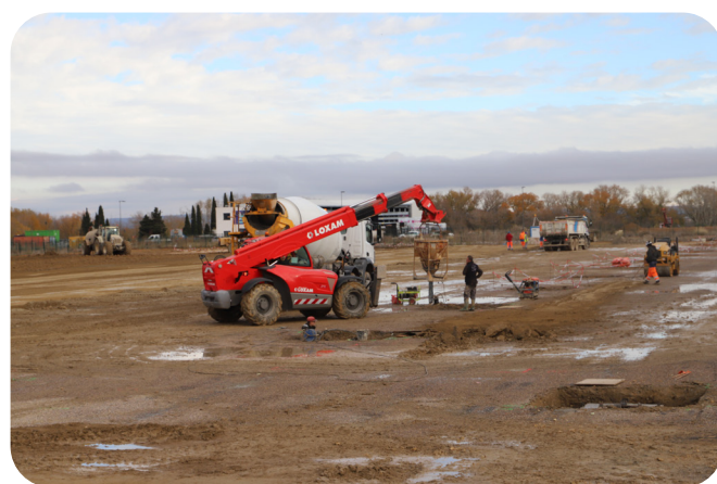
Extension de Narbonne Accessoires en construction
