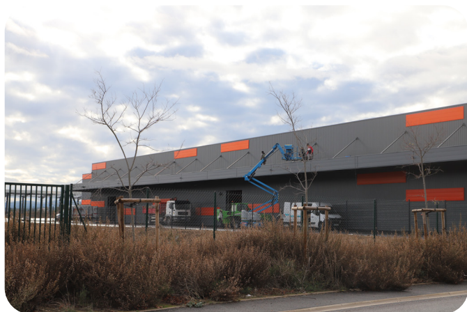
Finition et pose de panneaux photovoltaïques sur les bâtiments d'Alliantz
